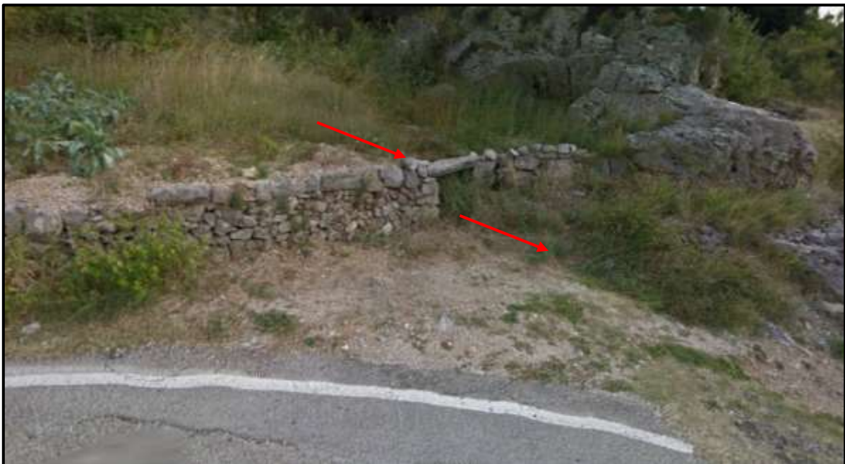
Slika 2.1-2. Bujica na stacionaži cca km 0+347 (glavni tok), neposredno južno od ulice Podraće, dionica na kojoj je planirana izgradnja sandučaste kinete (izvor: Google Earth)
